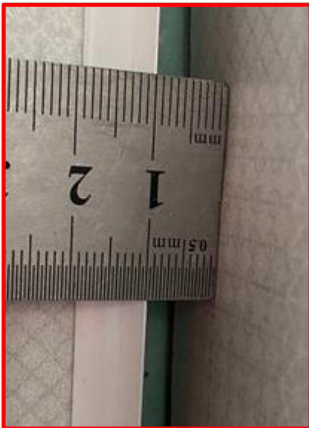
Фото 8. Зазор между перегородкой и стеной в санузле 10 мм
