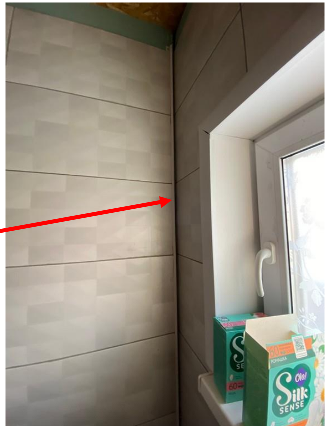
Фото 8. Зазор между перегородкой и стеной в санузле 10 мм
